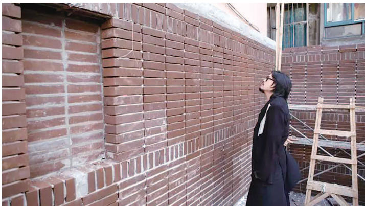
李亮聪在“时光轴”项目施工现场
