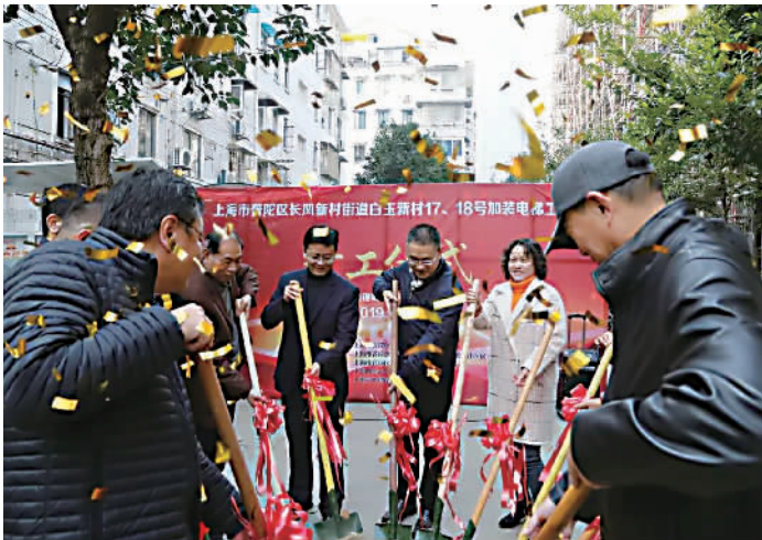
白玉新村17、18号楼加装电梯开工仪式
