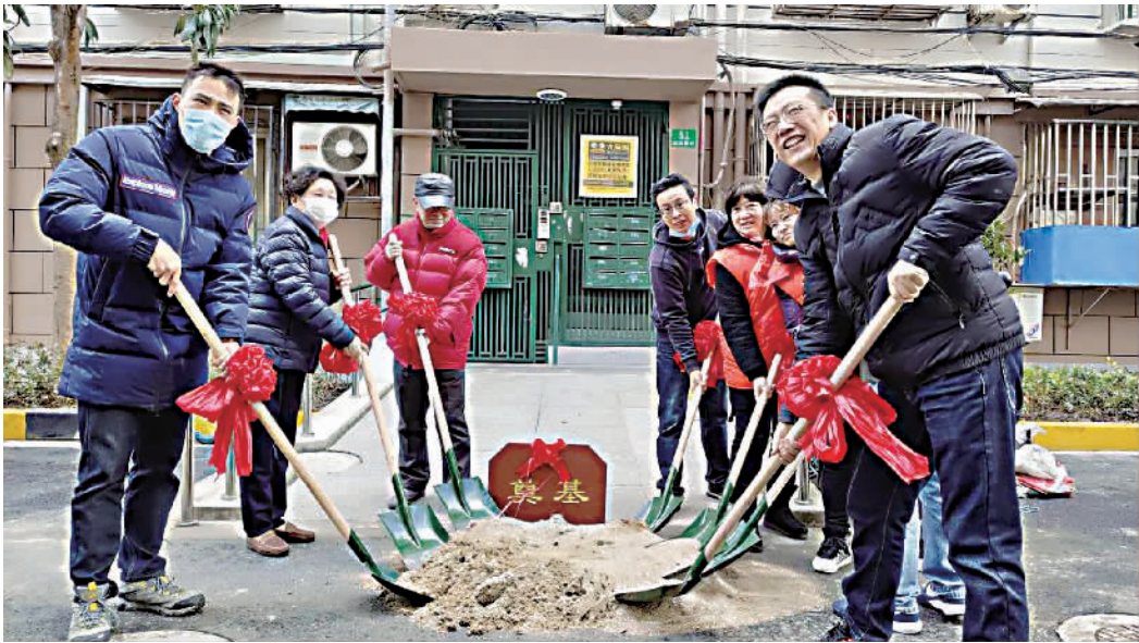
白玉新村 51 号楼加装电梯工程正式开启
