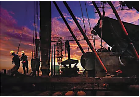
《打桩基》王贵林/摄
