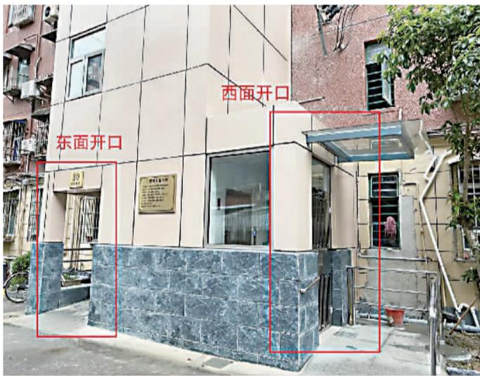
终设计出这样一套独特的方案——建成后的电梯将采用西进东出的方式,保留原先位于东面的大门,一楼居民的日常采光和通行就丝毫不受影响。在西面打通一扇新的门,作为一楼电梯的入口,因电梯为双开门电梯,居民搭乘电梯到达其他楼层后则从东面的电梯门进出,巧妙避开西面的楼梯口,一出电梯门就是平地走廊,也不用担心从楼梯掉落的风险。
