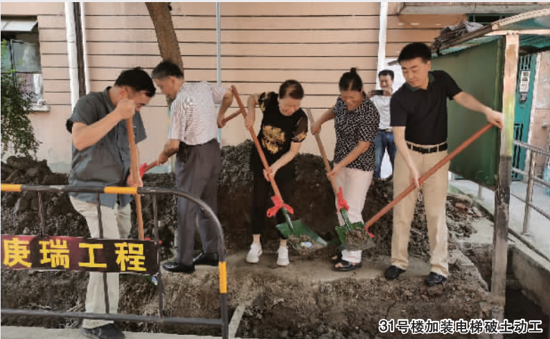
31号楼加装电梯破土动工
