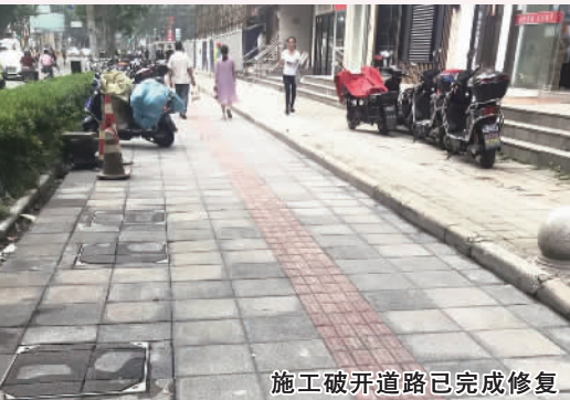
施工破开道路已完成修复
