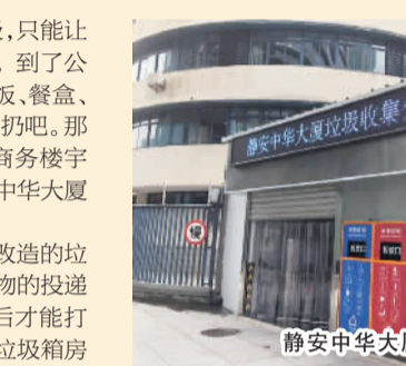
静安中华大厦垃圾收集分类站
