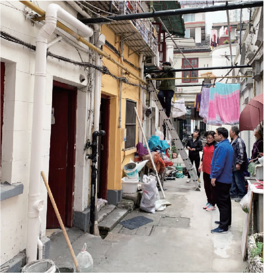
“一平方米”卫生间改造项目现场
