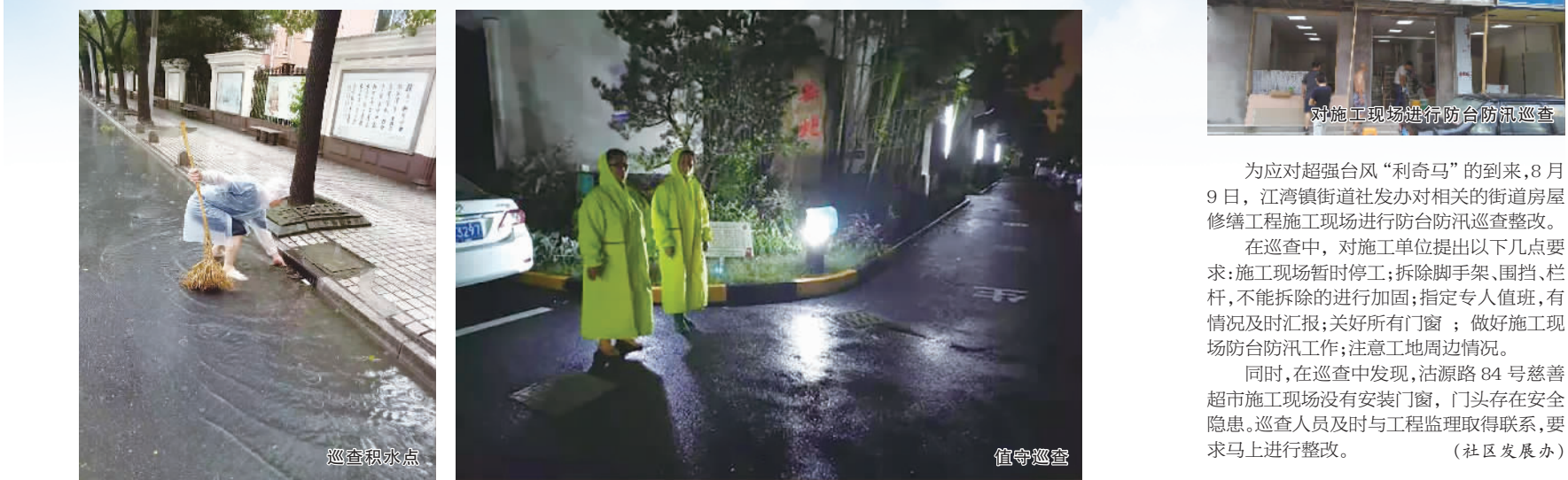
□记者 吴怡敏 巡查积水点 值守巡查 对施工现场进行防台防汛巡查
