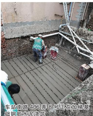
车站南路406弄8号正在加梯基础钢筋水泥浇筑
