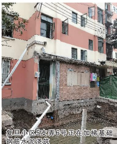
复旦小区5支弄6号正在加梯基础钢筋水泥浇筑
