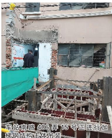
车站南路406弄15号正在进行加梯钢结构主体吊装
