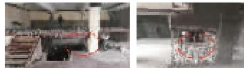
▲下挖地面造成沉重结构破坏 ▲破坏承重墙
