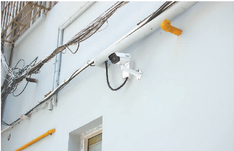
小区墙壁新加装监控摄像头
