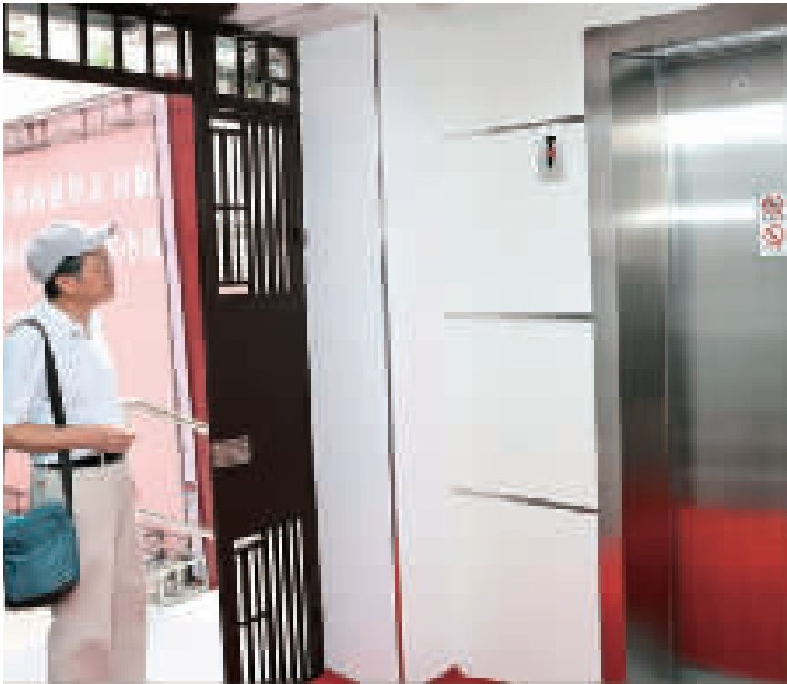
今年静安区开工建设既有多层住宅加装电梯要达 50 台 图片来源/上观新闻
