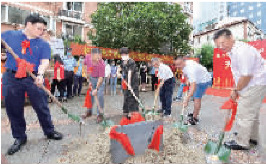
嘉宾和小区居民共同为电梯加装项目奠基
