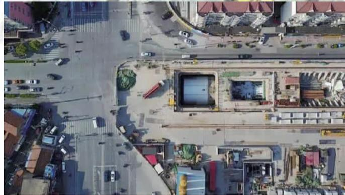
4车道,从浦西到浦东的车辆走下层车道,入口在周家嘴路近内江路;从浦东到浦西的车辆则走上层车道,出口在周家嘴路近爱国路。上下车道均为单向两车道,隧道及接线设计车速为60千米/小时。”
