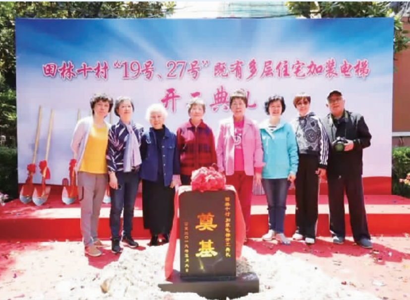
5月9日,田林十村既有多层住宅加装电梯开工
