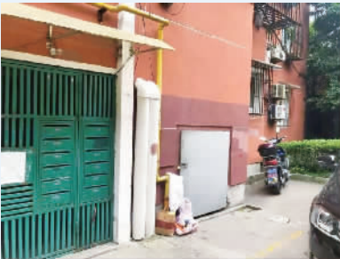
27号居民口电梯井安装位置
