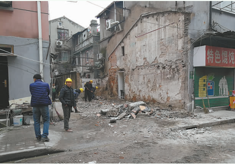
◀丹徒路 204号的 违章建筑 拆除前后
