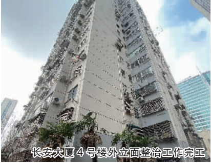
长安大厦 4 号楼外立面整治工作完工
