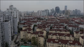
464弄地块东至中山西路,西至遵义路,南抵玉屏南路,北临长宁路,该地块旧改从 1982 年至 1989 年。图为该地块现状全貌, 摄影站位长宁路 1447 号“遵义东大楼”楼顶向南俯瞰
