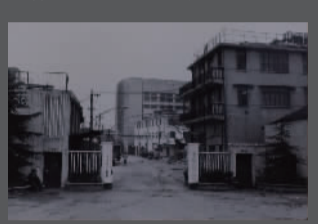
延安西路番禺路路口的上海第三制药厂(区地名办提供)
