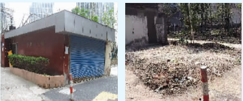
7月19日鲁班路721号车棚拆除前后对比图
