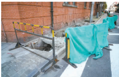
建筑外侧已立起防护设施
