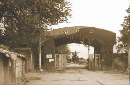
曾经的铁路南浦站大门。
