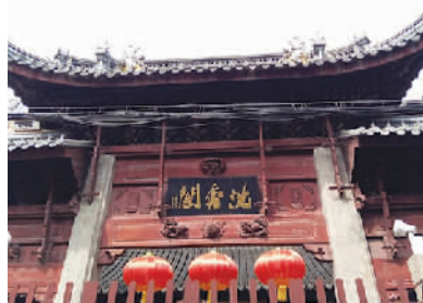
沉香阁前有修复的明代四柱三门重檐
