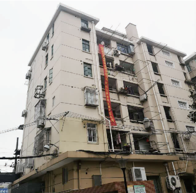
光机小区1、2号楼加装电梯开工建设中
