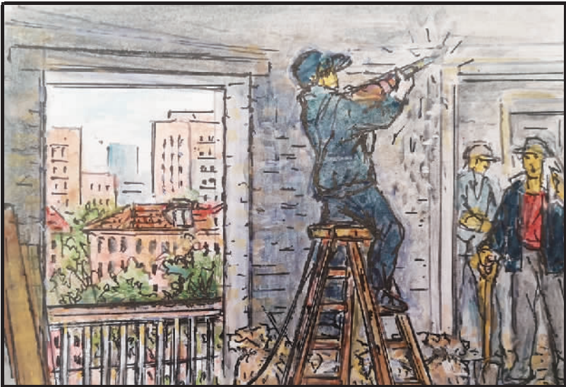
3 住房今比昔时好，高楼装修须注意。墙梁承重敲不得，居住安全尤重要。
